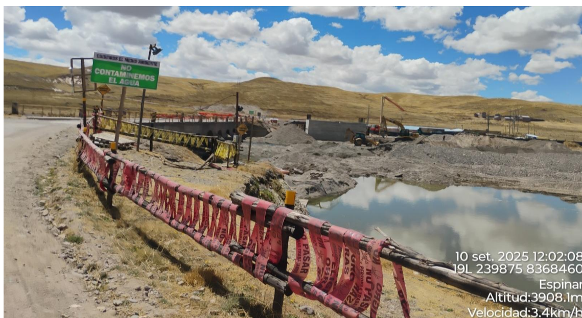
IMAGEN 01: TRAMO CRÍTICO EN LA MARGEN IZQUIERDA DEL RIO SALADO AGUAS ARRIBA DEL PUENTE SANTA LUCIA, RIESGO A EROSIO DE TALUD.
